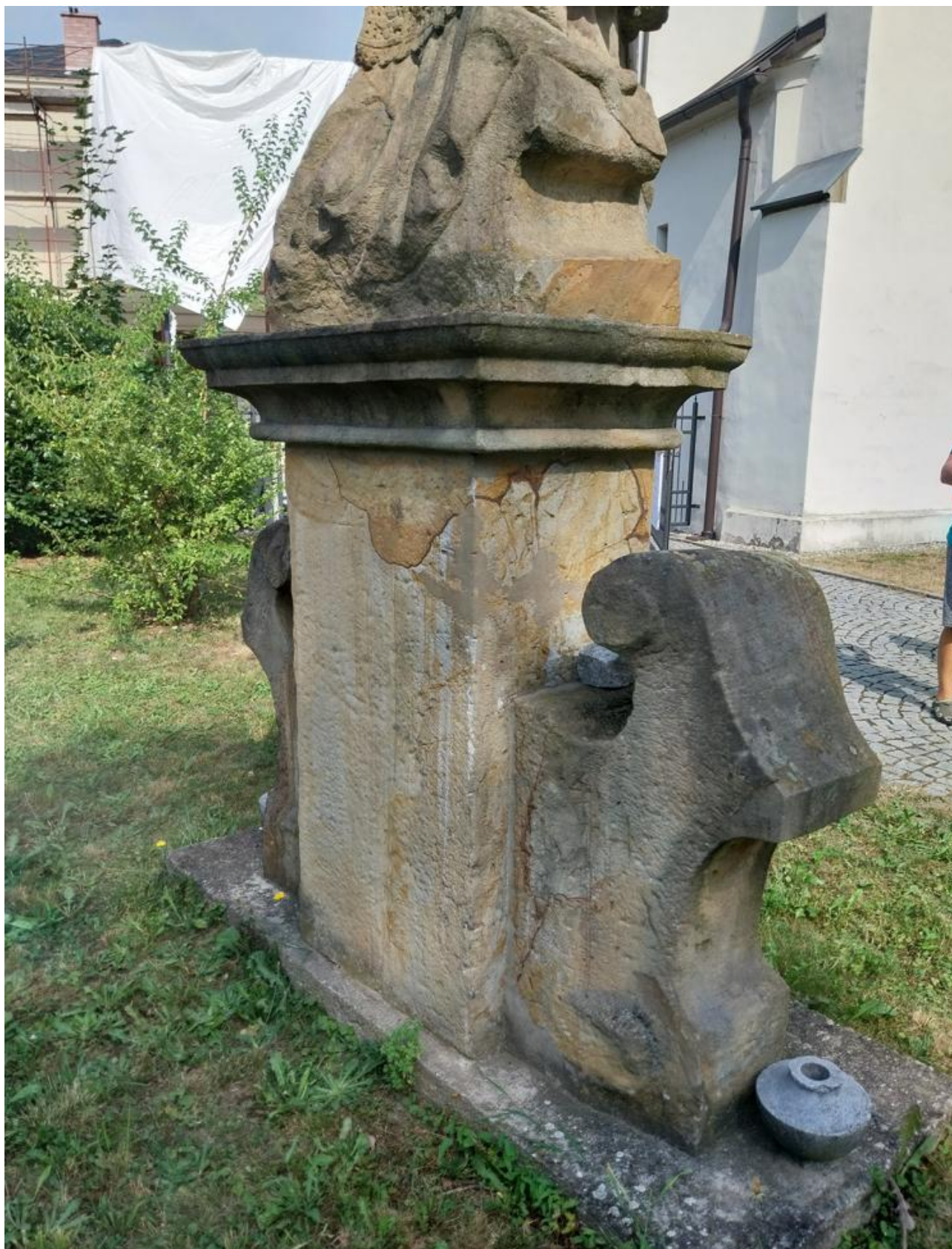
Zadní pohled na podstavec. Celá statue stojí na pevném betonovém základu, na plochách podstavce je vidět množství tmelů z předchozích obnov.
