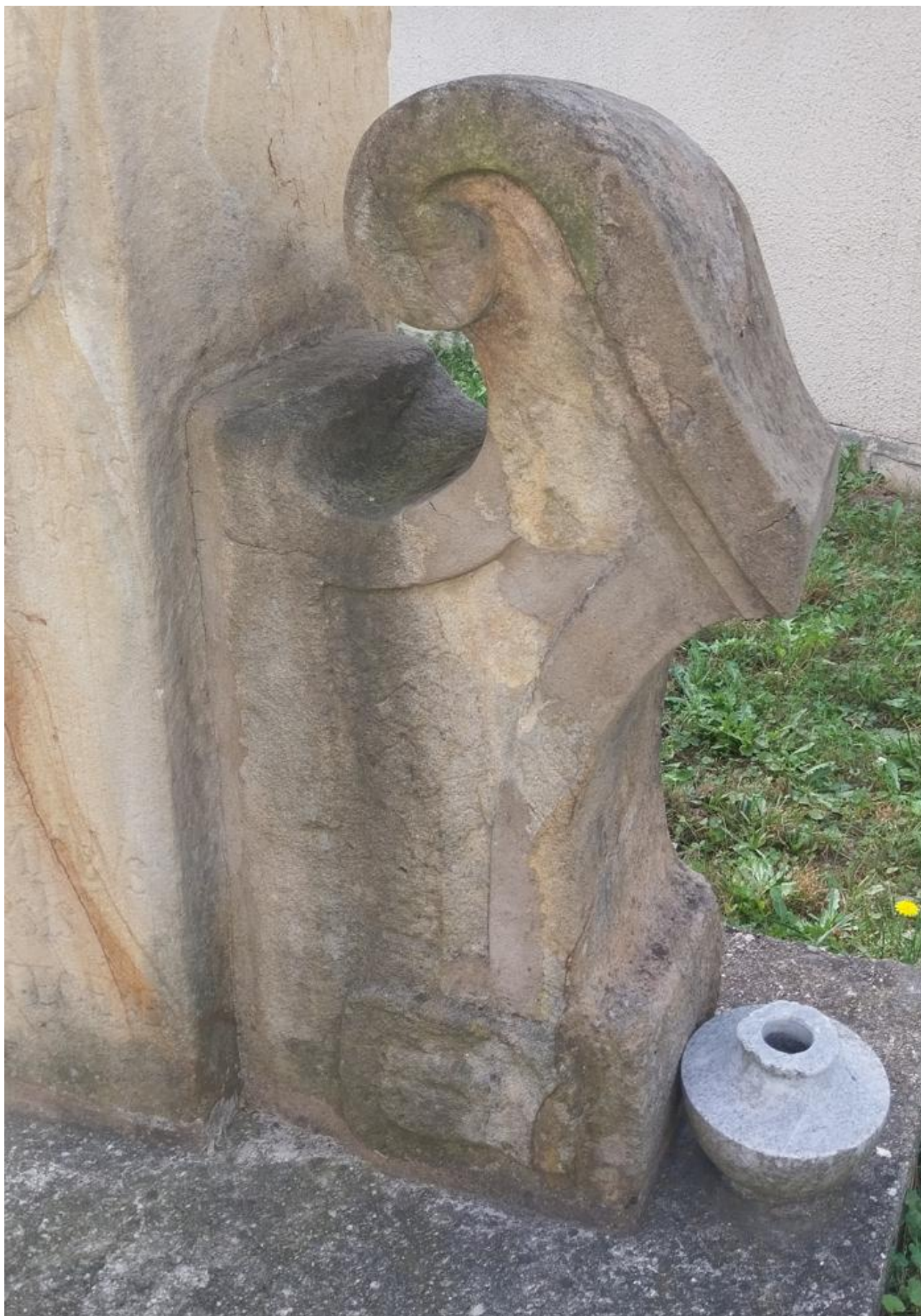
Tmely z předchozí opravy mění barvu a počínají se oddělovat od originálního kamene.
