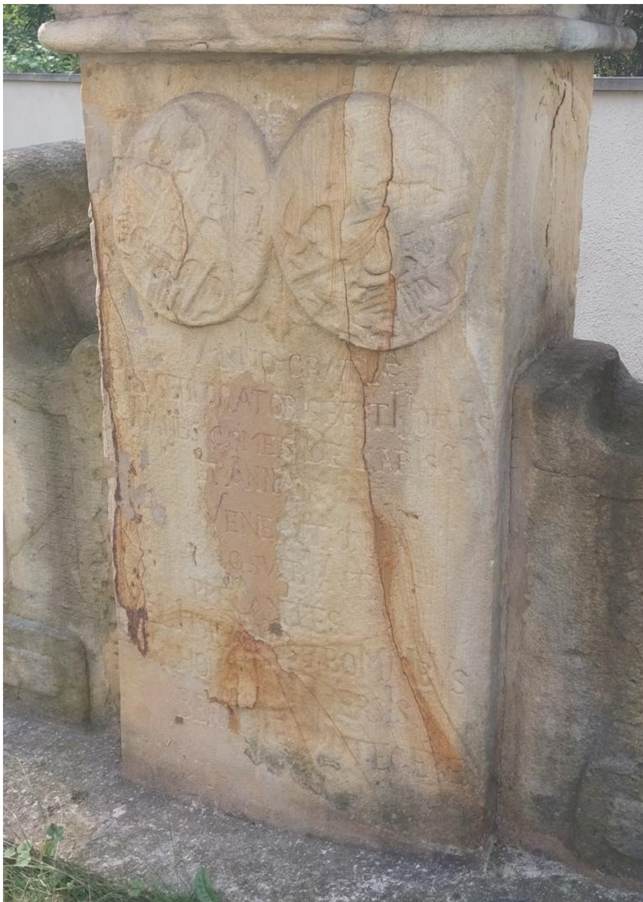
Značně narušený stav kamene podstavce. Povrch kamene se drolí a písmo i erby začínají být nečitelné.
