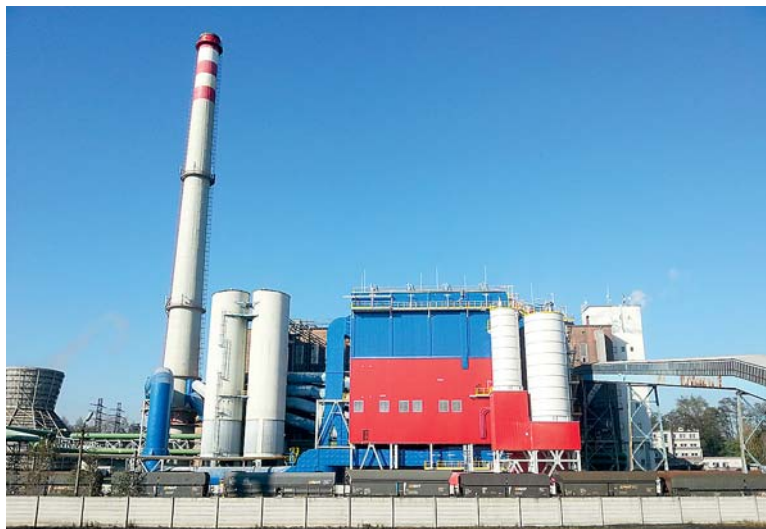
VEOLIA – TEPLÁRNA KARVINÁ – investuje pravidelně do ekologických vylepšení. V popředí odsířovací technologie spalin všech čtyř kotlů.
