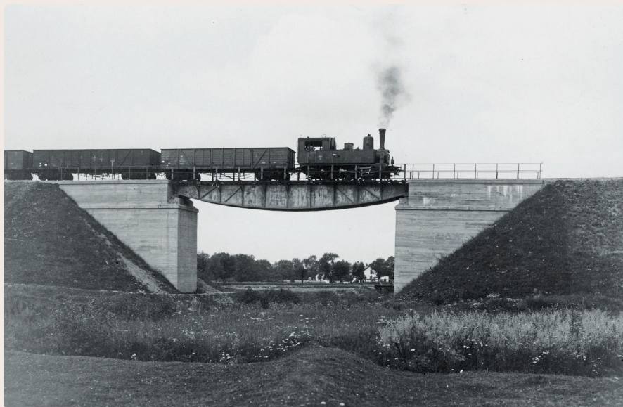
Dawny wiadukt kolejowy w Jastrzębiu-Zdroju
