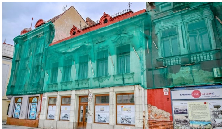
Nynější podoba objektů před zahájením rekonstrukce
