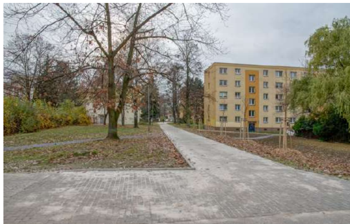
Rekonstrukce chodníku, výsadba stromů a vytvoření květnaté louky v Mizerově
