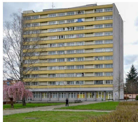
Bytový dům seniorů na ulici Borovského v Ráji
