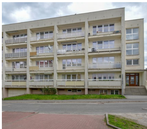
Bytový dům seniorů na ulici Markova ve Fryštátě
