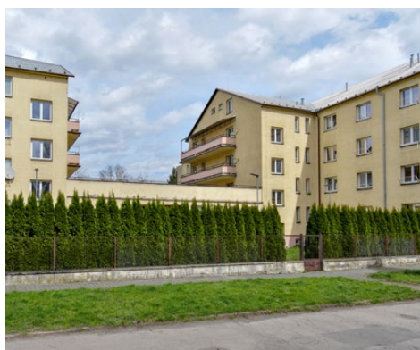
Bytový dům seniorů na ulici U Svobodáren v Novém Městě
