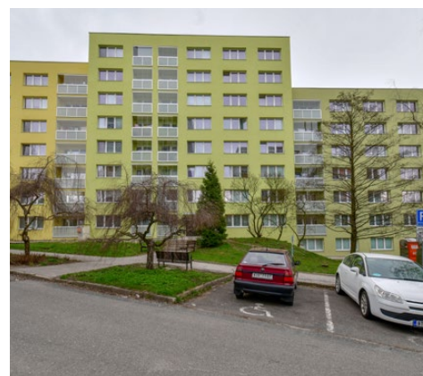
Bytový dům seniorů na ulici U Lesa v Ráji
