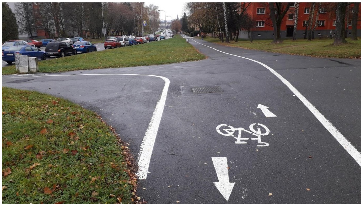
Obrázek 69 Stezka pro chodce a cyklisty bez dělicího varovného pásu pro nevidomé a slabozraké
