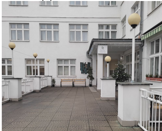
Detail vstupu do budovy
