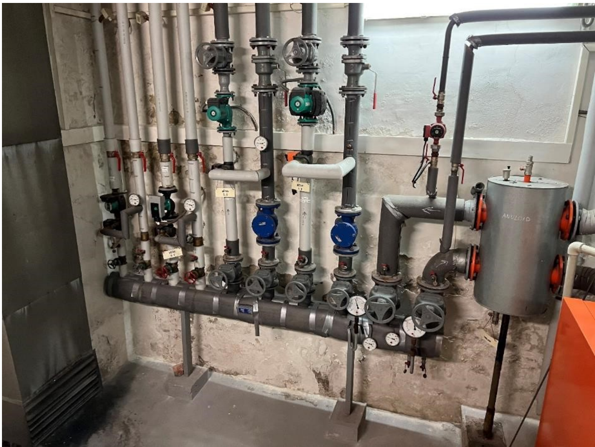
Obr. Rozdělovač / sběrač topné vody
