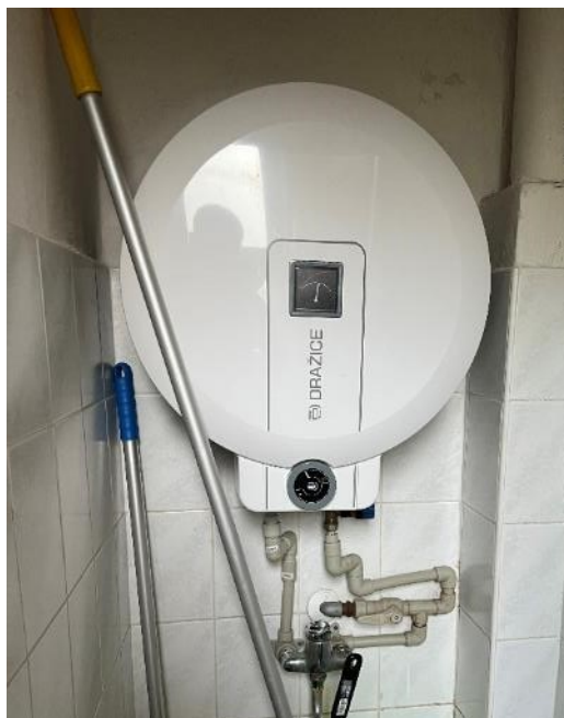
Obr. Lokální elektrické ohřivače teplé vody
