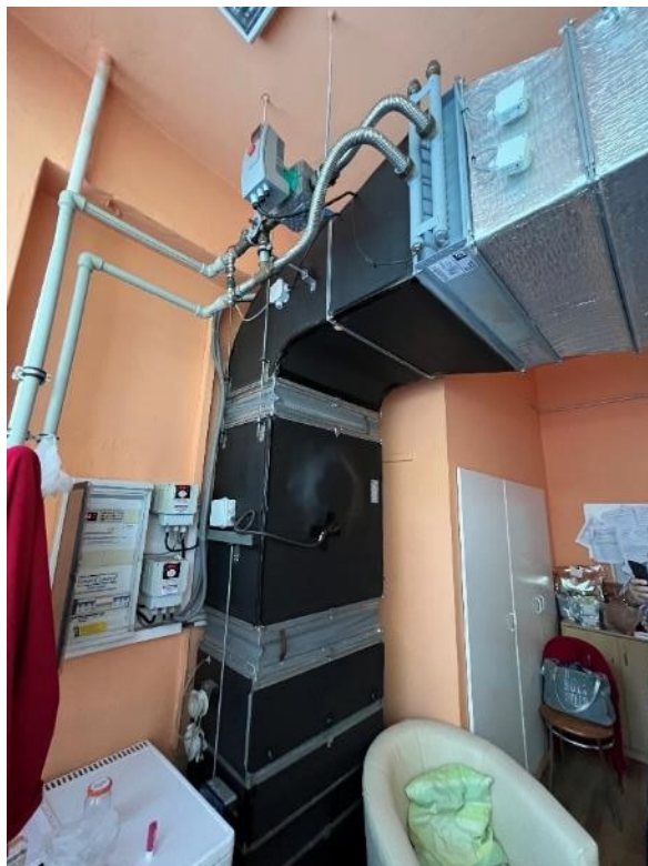
Obr. Regulační uzel pro výměník VZT
