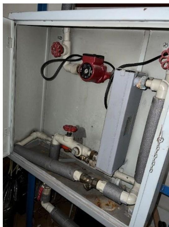
Obr. Výměník TV
